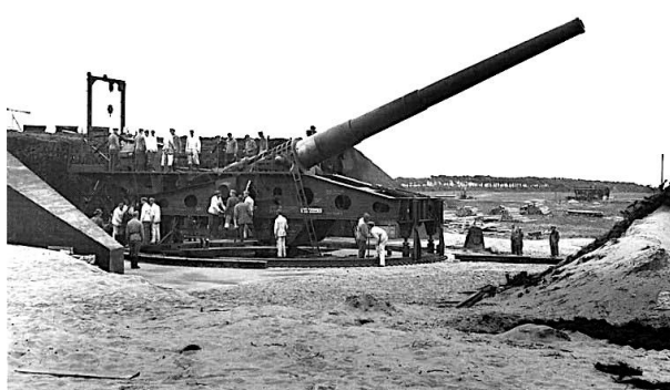
La batterie du Bégot à Plouharnel
