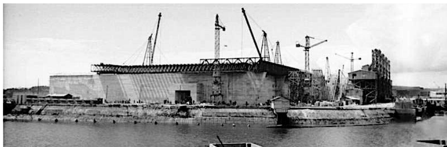
Photo du suivi de la construction de la base.
