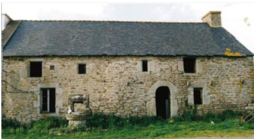
La forme rectangulaire caractéristique de ces maisons dites localement « longères » est visiblement liée à la longueur des poutres limitée par la taille maximale atteinte par les arbres locaux.
