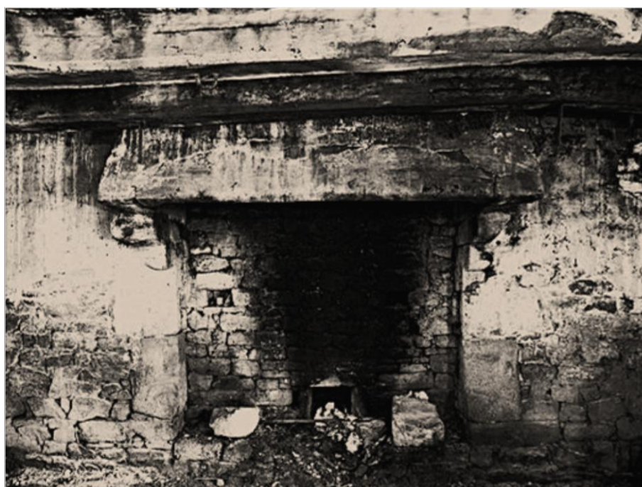
Cheminée intégrée avec hotte saillante à faux-manteau avec linteau de bois s'appuyant sur les corbelets
